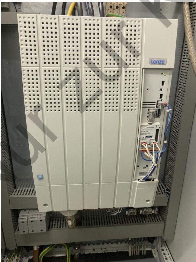
Bild 10 Frequenzumrichter Gebläse
