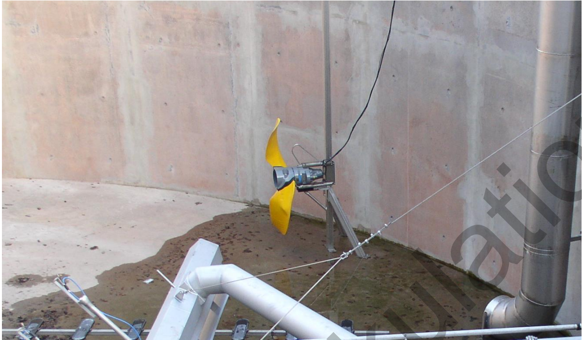
Bild 7 Rührwerk Bestand
