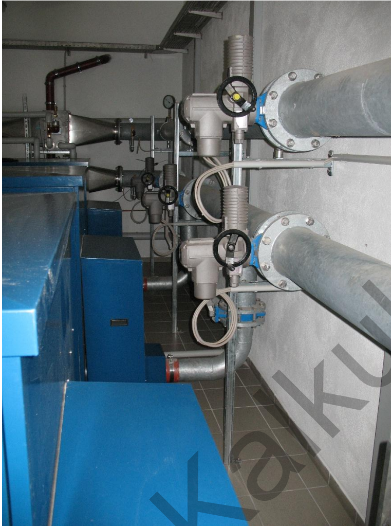
Bild 3 Bestandsverrohrung Gebläse in BGB
